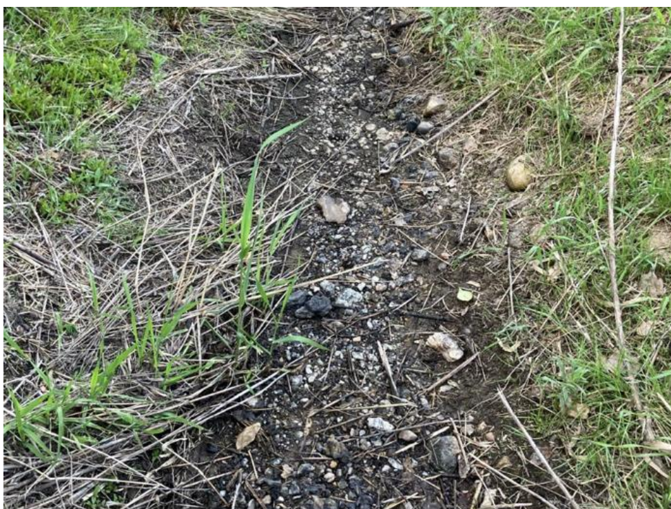
Grusbund på udtørret del af strækning 1 i maj 2025
