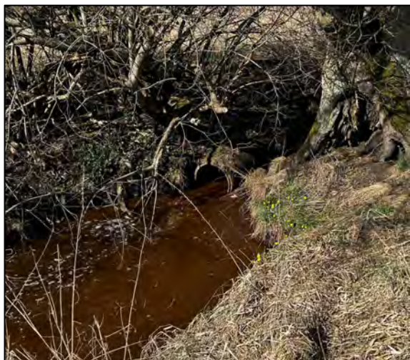
Figur 4: Rørudløb af den rørlagte strækning ved st. 2.023 m.
