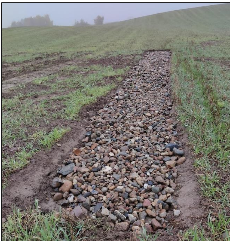
Figur 19: Eksempel på en nyanlagt overløbskarm fra et lignende lavbundsprojekt.
