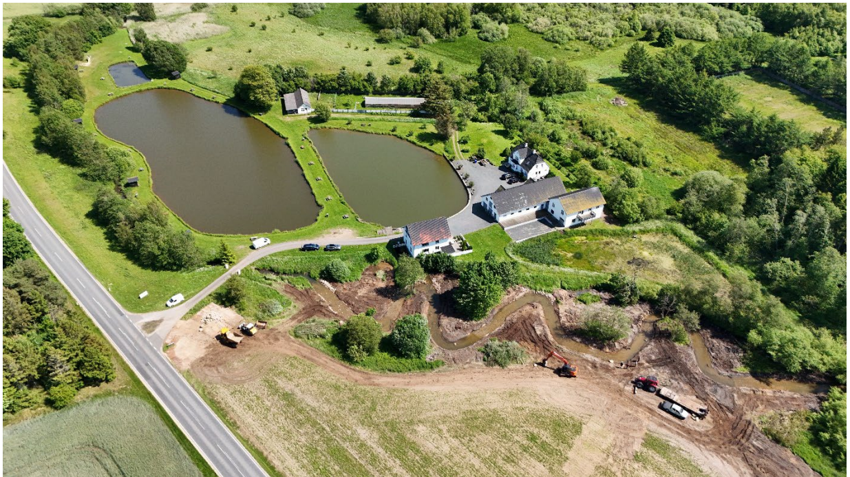
Droneoptagelse under anlæg (fotograf: Claus Moestrup, Favrskov Kommune)
