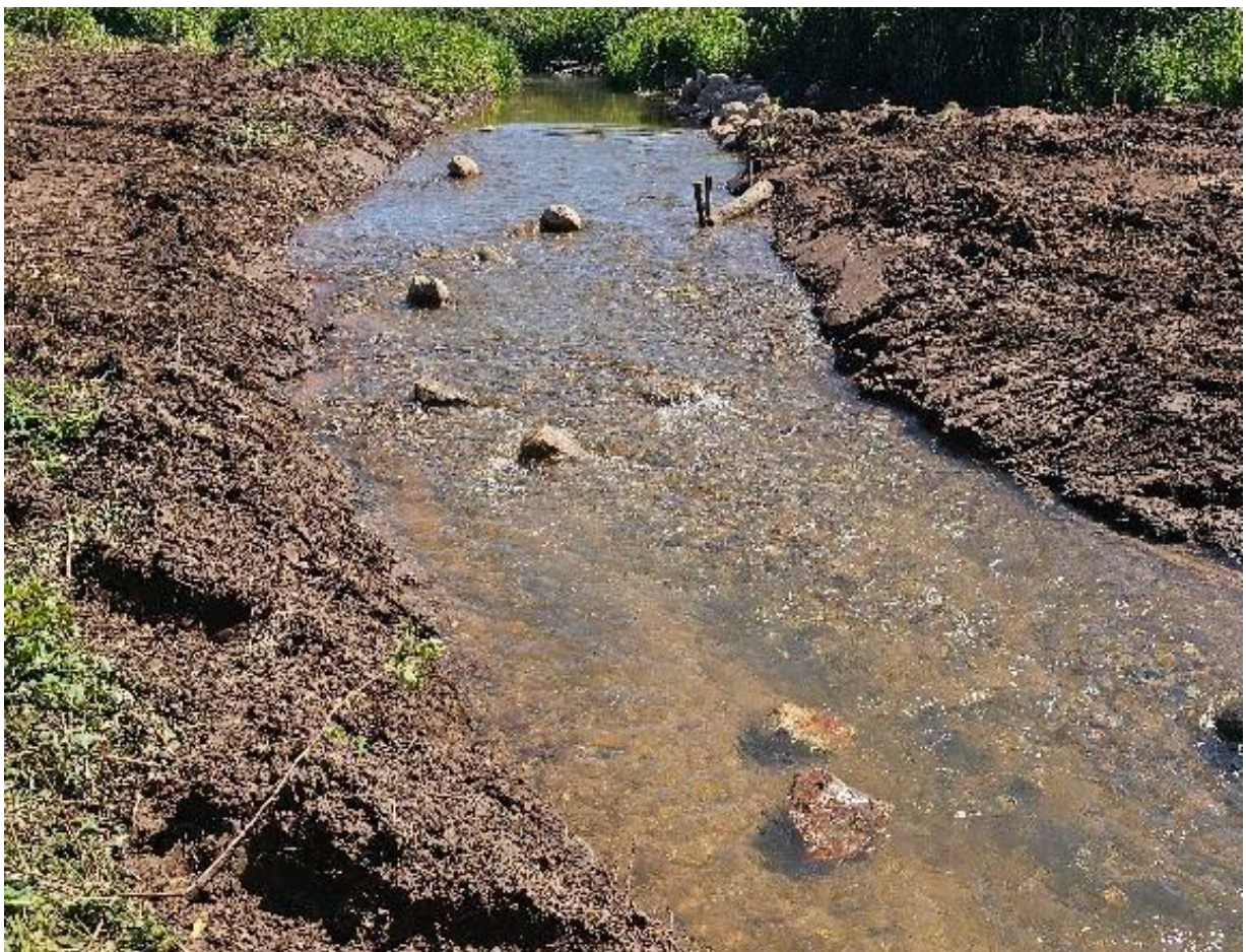
Eksempel på gydebanke udlagt i det nye genslyngede tracé
