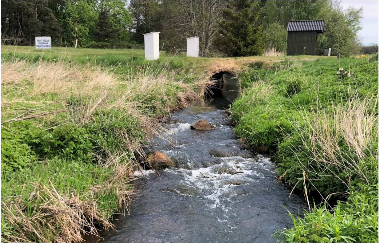
Billede af spærring før projektgennemførelse
