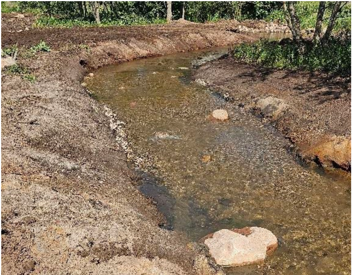
Eksempel på gydebanke udlagt på i det nye tracé
